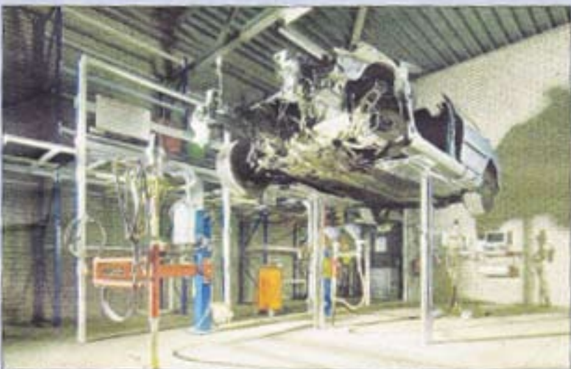
Afzuiginstallatie. Een speciale afzuiginstallatie verwijdert diverse vloeistoffen die nog in auto's aanwezig kunnen zijn. De onderdelen worden vervolgens gerepareerd voor hergebruik.
